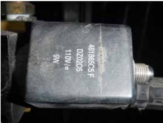
310V023 LPGT冷却空気止弁
